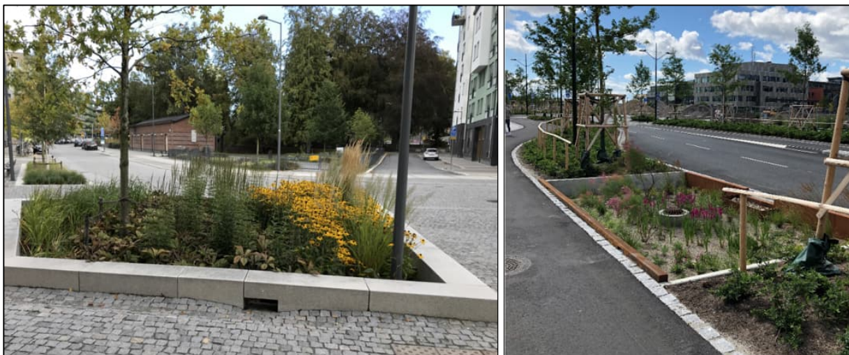
Figur 15. Exempel på nedsänkta regnbäddar (Foton: Norconsult).
