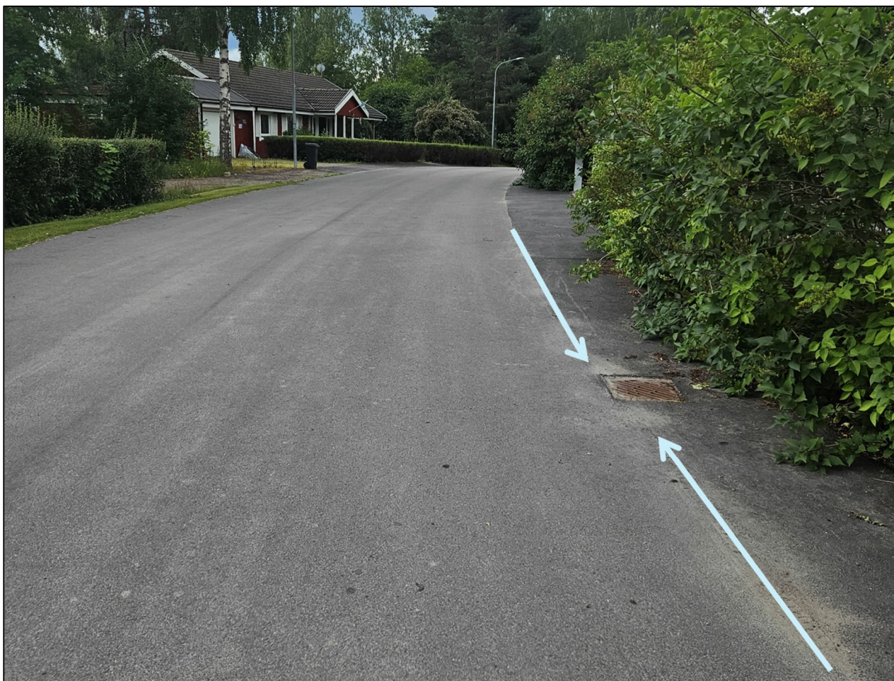
Figur 23. Lågstråk med avledning mot dagvattenbrunn på Blåbärsstigen. Foto: Norconsult.
