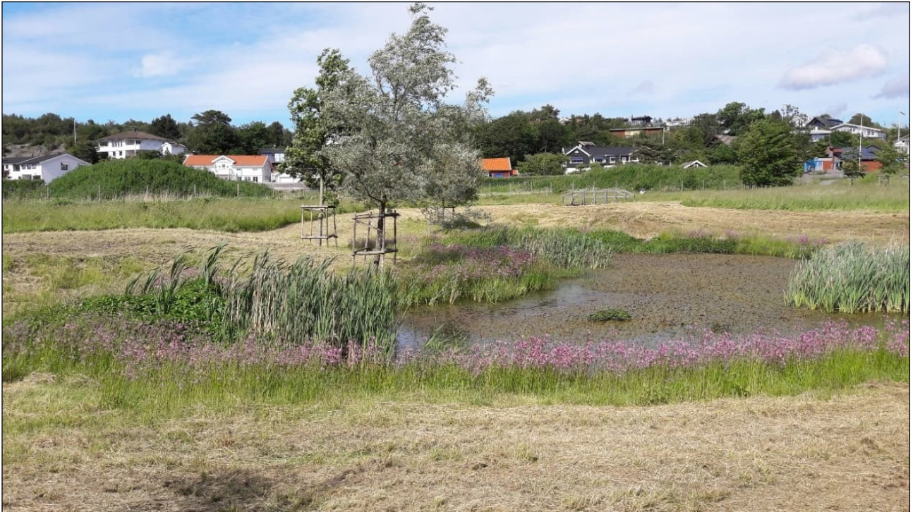
Figur 13. Exempel på dagvattendamm i Brottkärr. Foto: Norconsult
