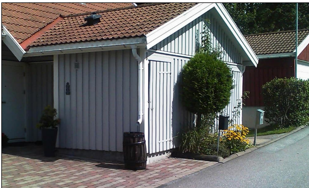
Figur 19. Utnyttjande av dagvatten med hjälp av uppsamling i regntunna. (bild: Norconsult)
